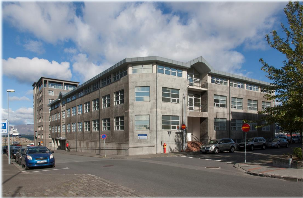
Sölvhólsvegur þar sem FJS var áður til húsa
